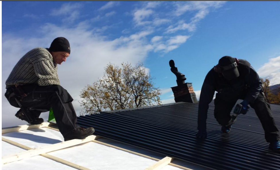
Takarbeider Jon Holm og Morten Nymoen. Taket ble lagt i forlengelsen av hyttetaket.
